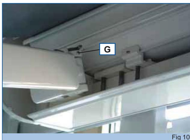
12. Si los codos no están alineados, opere el tornillo sin cabeza (G-Fig. 10) en los soportes de los brazos. Apriete el tornillo sin cabeza para elevar el
